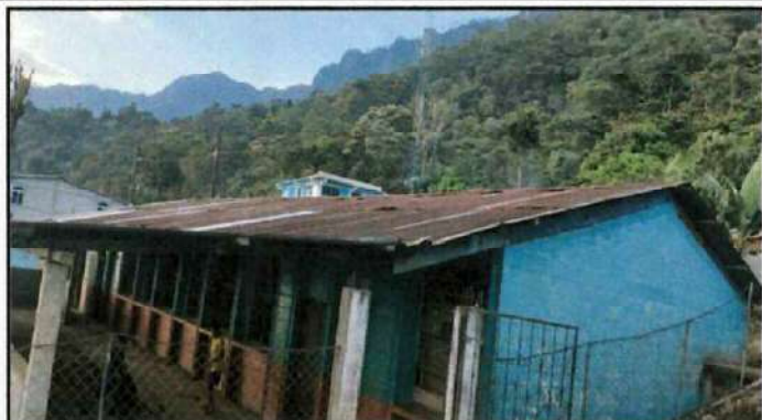
Foto1: En esta fotografía se observa la necesidad de la escuela de sustituir el entechado a láminas troqueladas.
